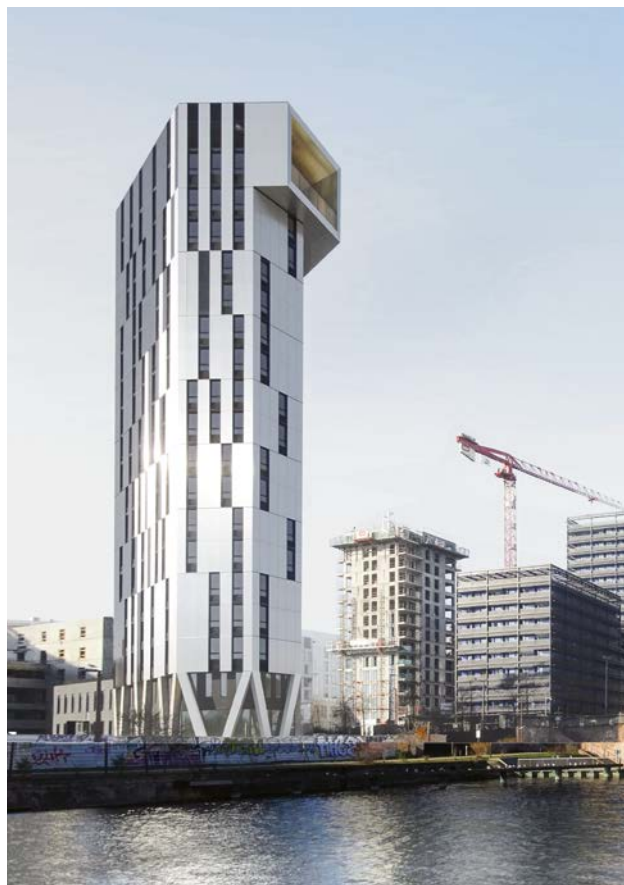
Plusenergie-Hochhaus Tour Elithis Danube in Strasbourg mit dunklen PV-Modulen an den Fassaden (XTU architectes, 2018).
