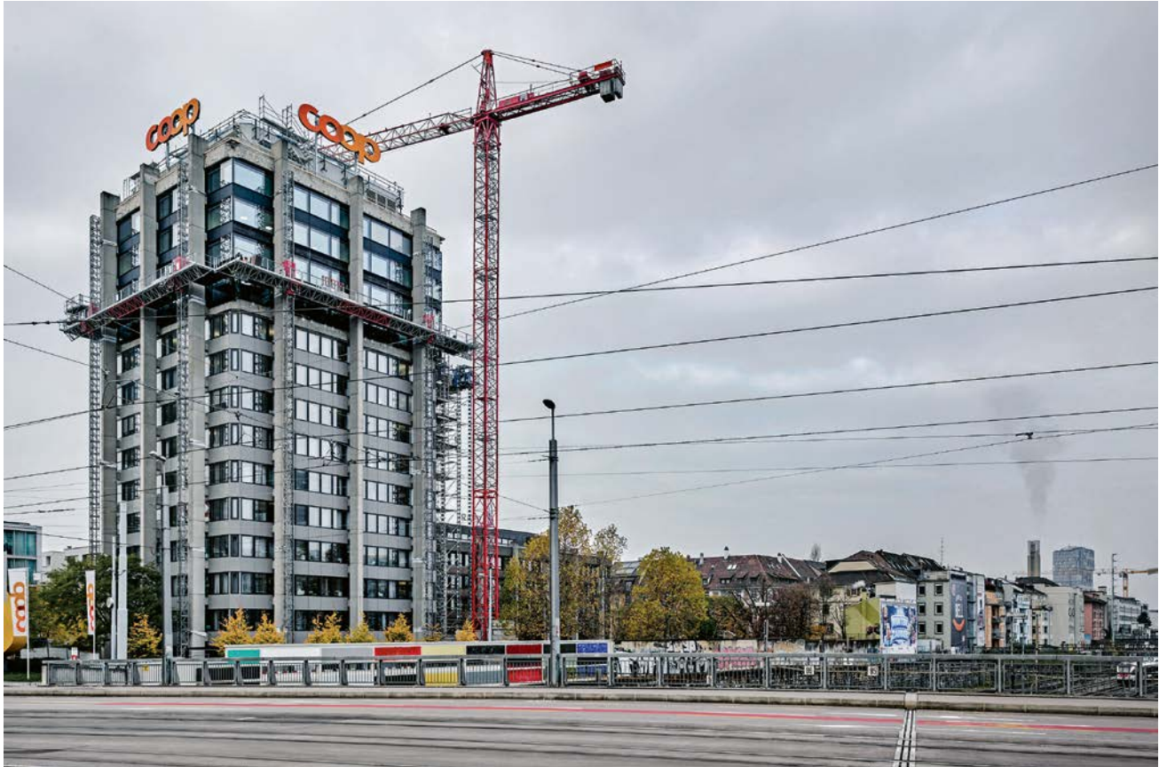
Von oben nach unten: Bei der Totalsanierung des Coop-Hauptsitzes in Basel (Burckhardt+Partner) erhalten die Aussenfassaden ein solares Facelifting. Die Brüstungsbänder werden neu mit anthrazitfarbenen PV-Modulen verkleidet.
