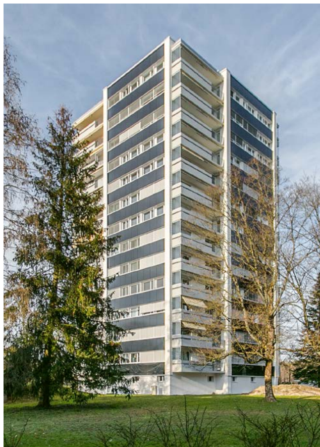
Saniertes Hochhaus in Effretikon ZH, neu mit PV-Modulen an den Brüstungsbändern (Generalplanung: Arento, 2019).
