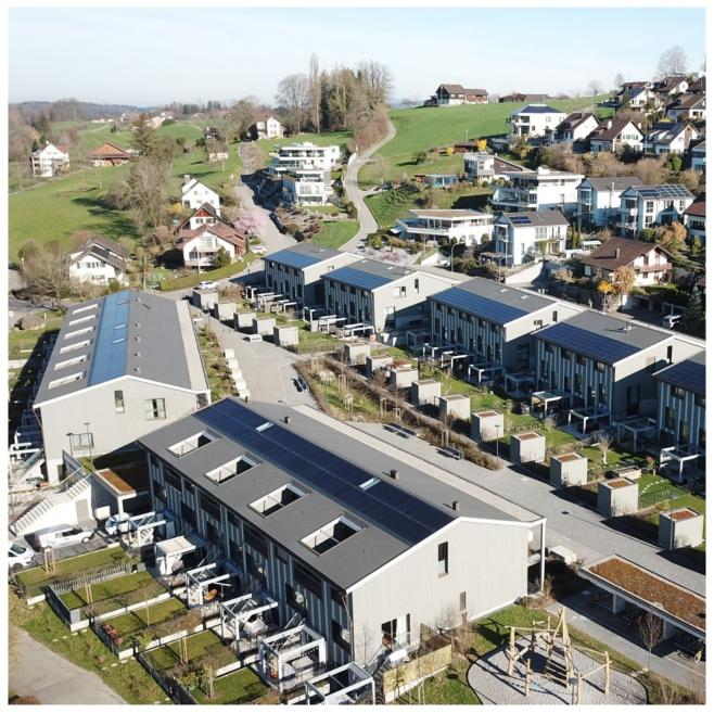
Fläche in m<sup>2</sup>: 238.7 | Leistung in kWp: 53 | Realisation: 2021
