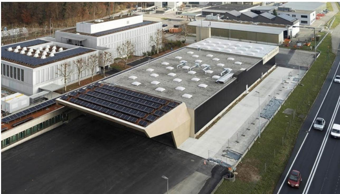
**Fläche in m<sup>2</sup>:** 300 | **Leistung in kWp:** 170 | **Realisation:** 2025
