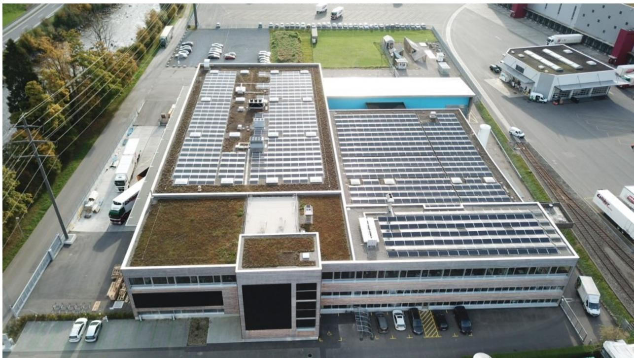
**Fläche in m<sup>2</sup>: 4700 | Leistung in kWp: 471.24 | Realisation: 2018**
