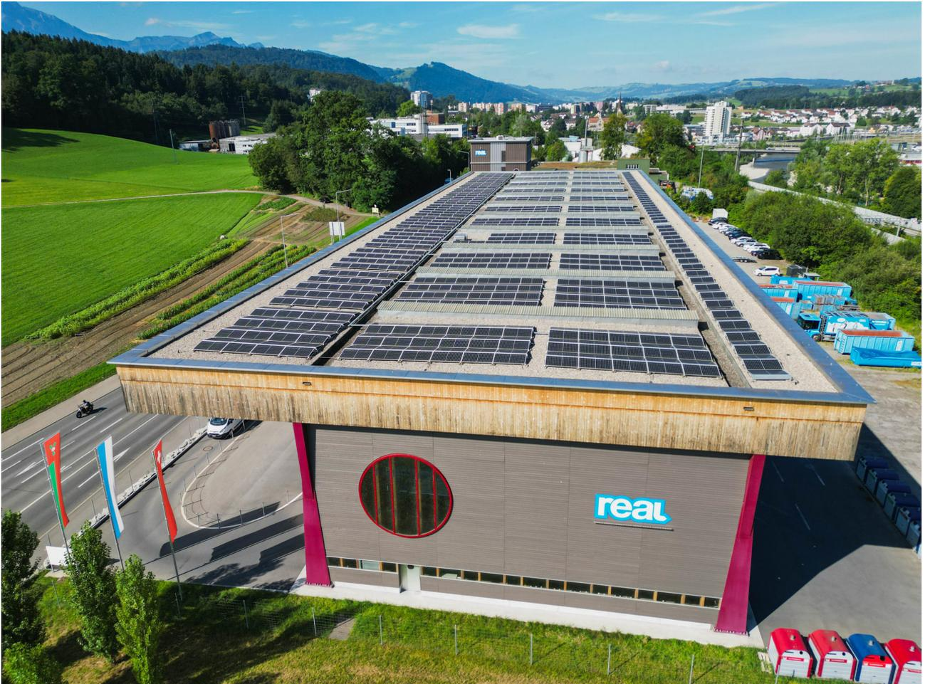
**Fläche in m<sup>2</sup>: 755 | Leistung in kWp: 449 | Realisation: 2020**
