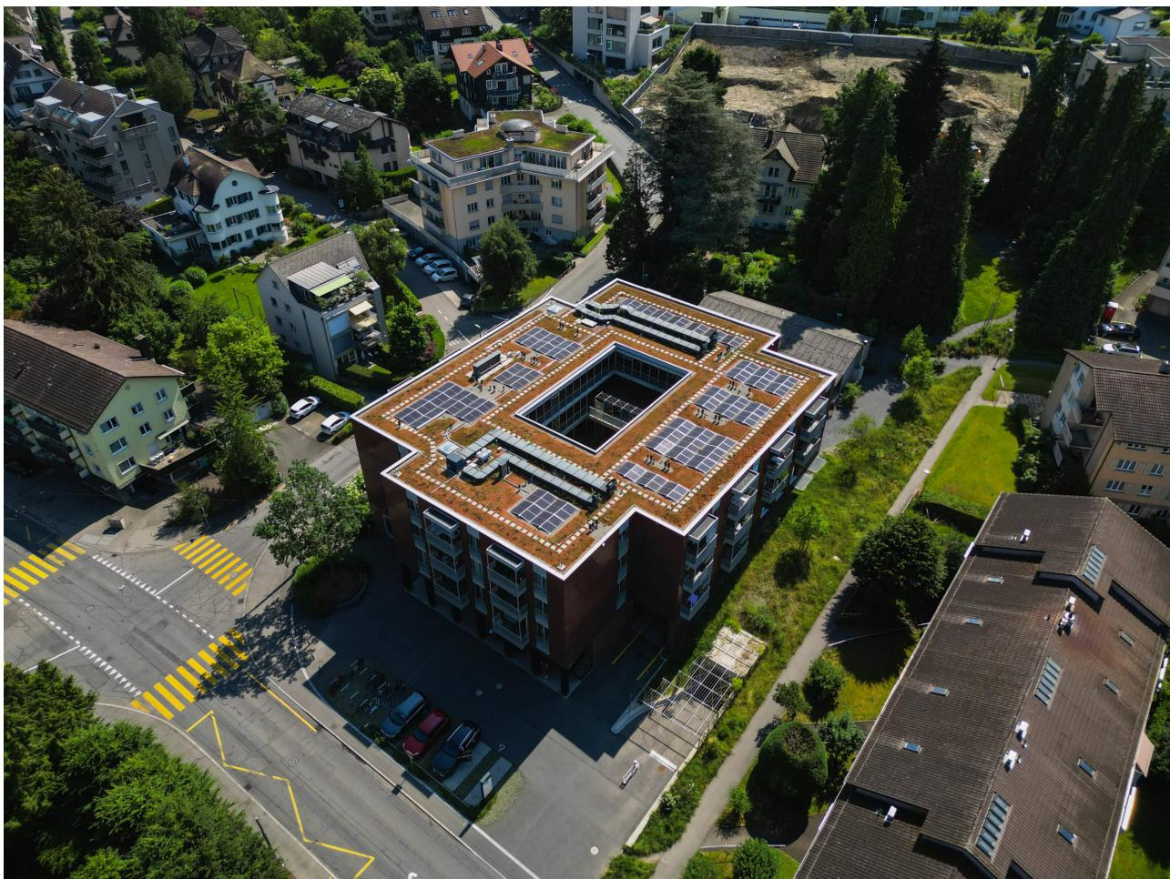
**Fläche in m<sup>2</sup>: 200 | Leistung in kWp: 39.59 | Realisation: 2021**
