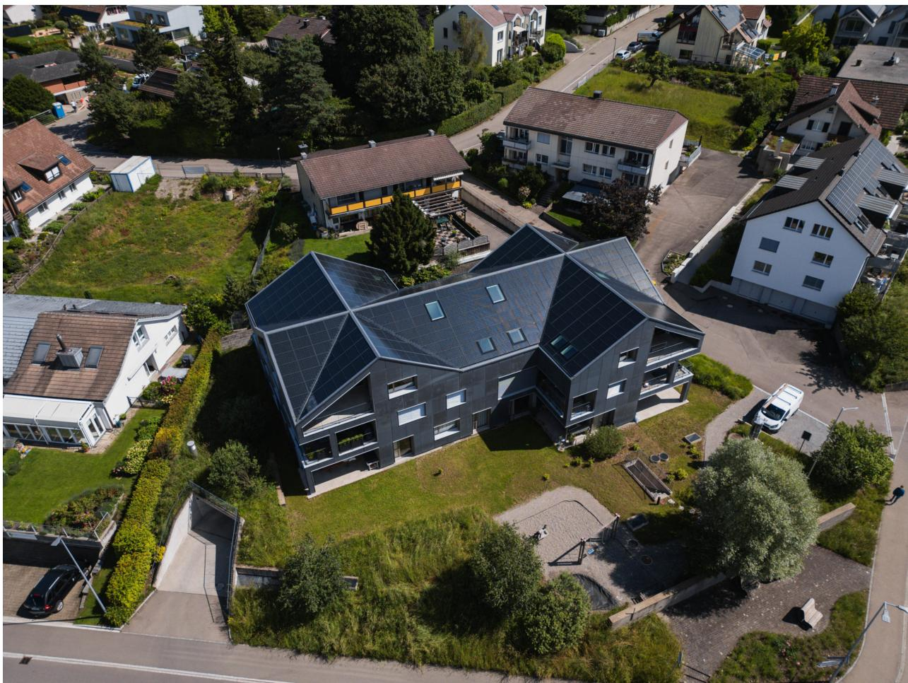
**Fläche in m<sup>2</sup>: 997 | Leistung in kWp: 126.5 | Realisation: 2016**
