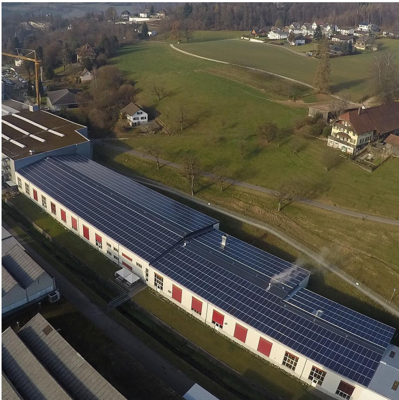
**Fläche in m<sup>2</sup>: 2596 | Leistung in kWp: 421.47 | Realisation: 2016**
