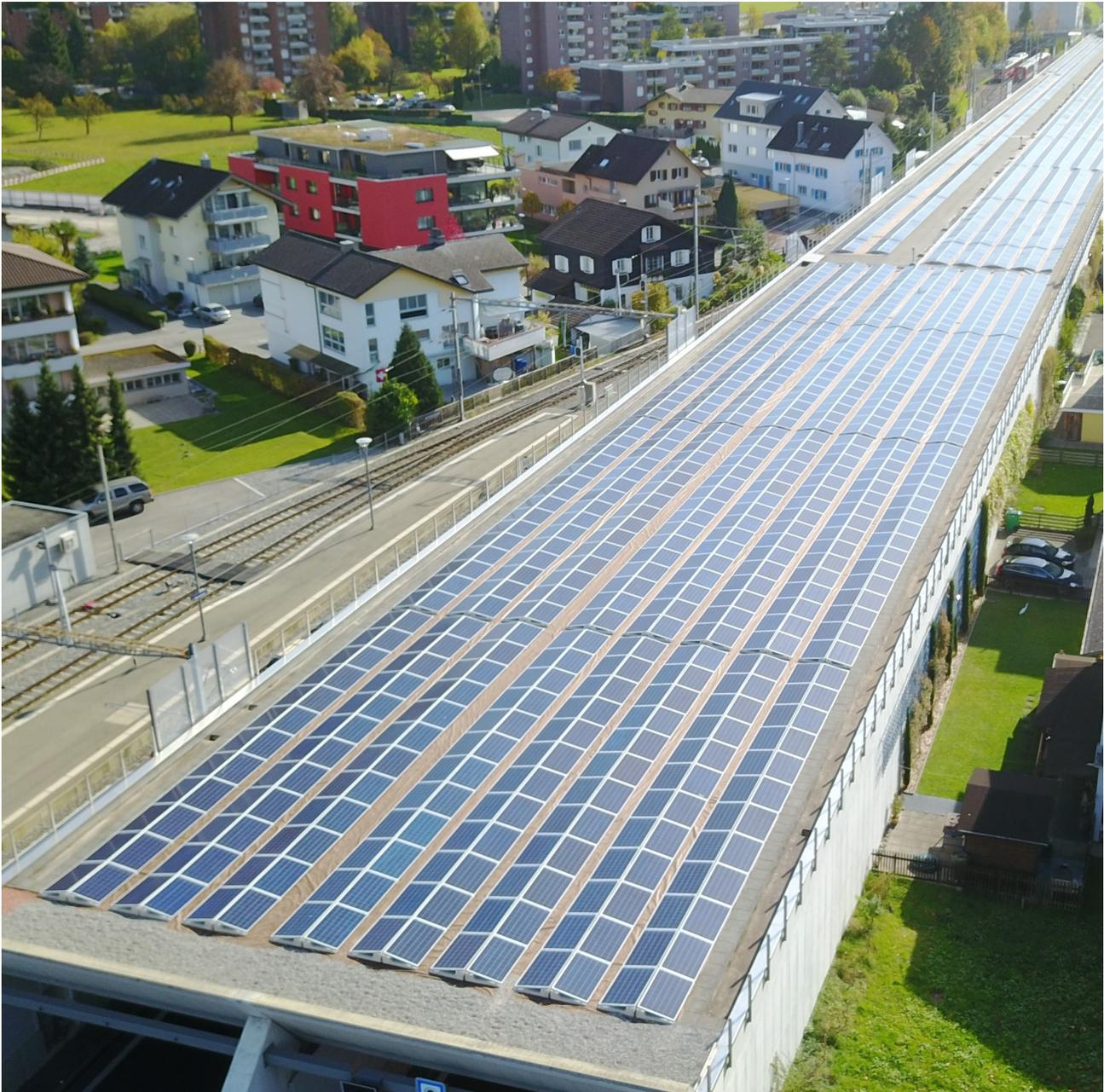
**Fläche in m<sup>2</sup>: 4300 | Leistung in kWp: 841 | Realisation: 2017**
